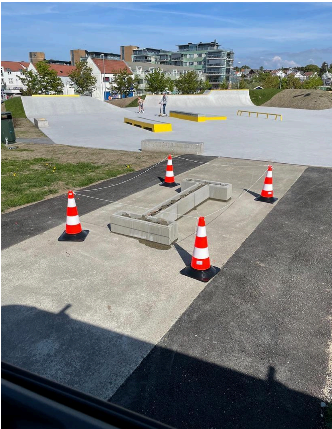
Første lag med betong i fot/støtten
